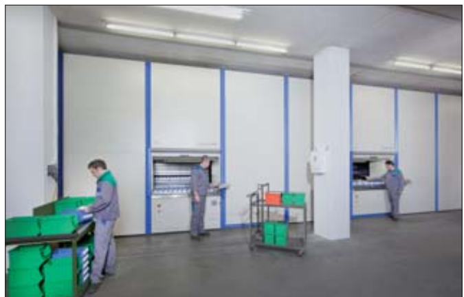
To Hänel Multi-Space® enheder, hver i en bredde på 9,57 m, udgør det centrale lager i produktionshallen
